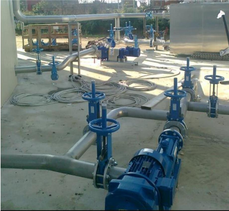
Figura 4.7: Piping nei dintorni dei digestori
