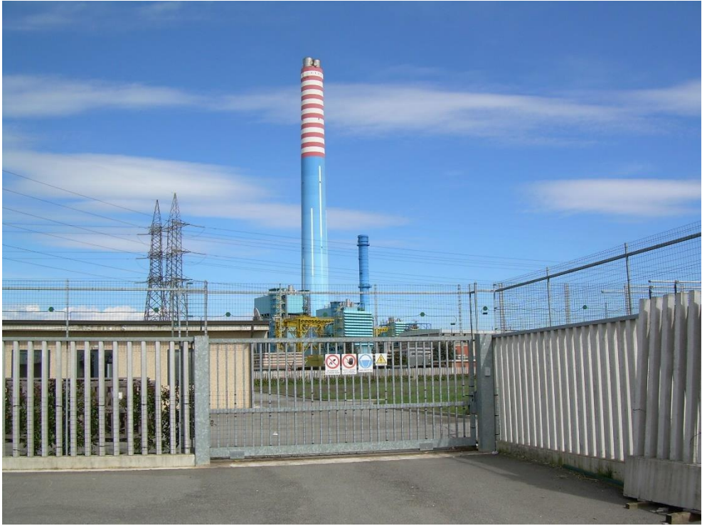
Figura 3.15: Centrale termoelettrica di Cassano d'Adda
