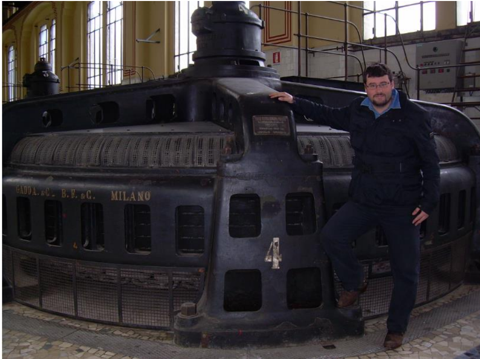
Figura 2.13: Gruppo con turbina Kaplan
